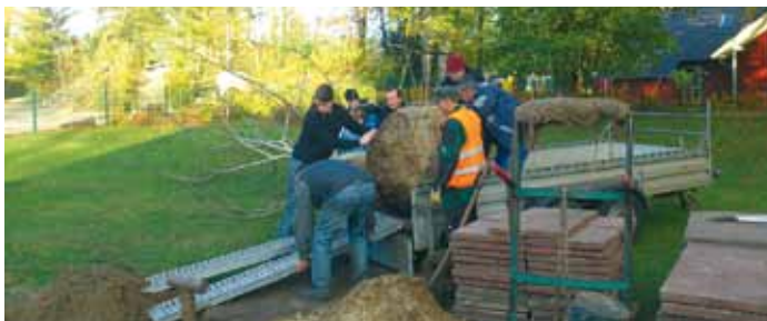
Der erste Arbeitseinsatz am Schwedenheimpark, Herbst 2013
