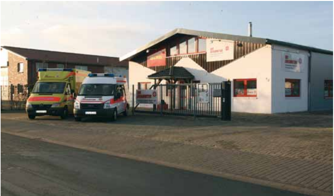
Gebäude des Ortsverbandes der Johanniter in Garrel im Eichkamp 19 mit Einsatzfahrzeugen
